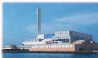
工場の新設・長寿命化工事
