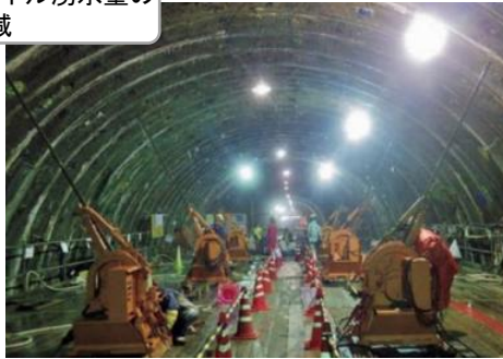
熊谷組・RPG工法
