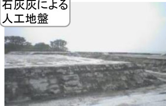
日本国土開発・ 石炭灰を利用した人工地盤
