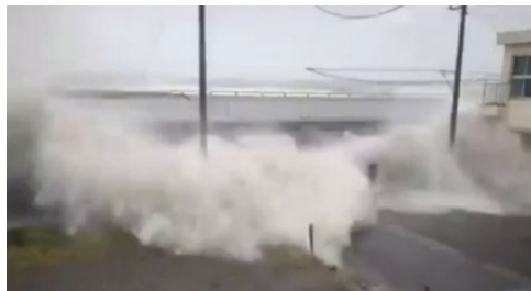
小田原海岸における越波の状況
