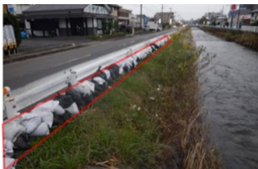
嵩上げコンクリート工事の実施
