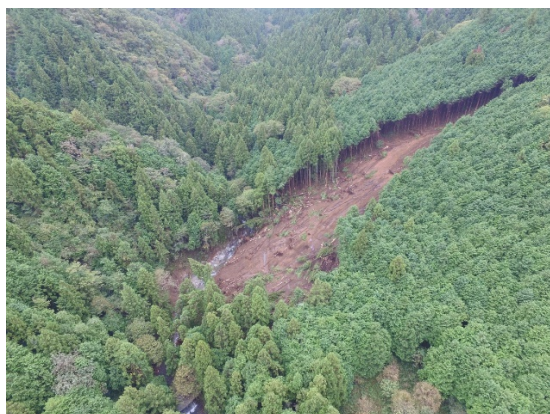
ドローンを使用した上空からの空撮による崩落現場の確認
