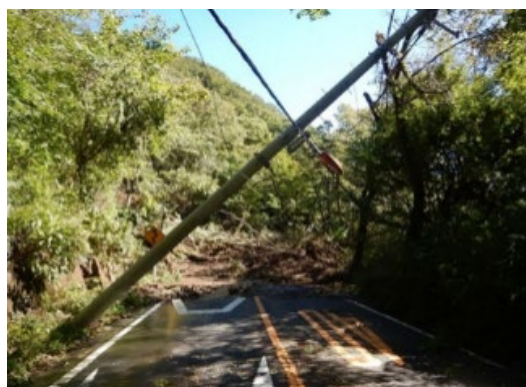
令和元年台風第 19 号の豪雨により、斜面が大規模に崩壊し道路が閉塞した国道 138 号（箱根町）
