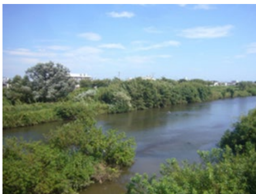
河床掘削・樹木伐採の実施
