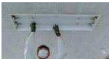
照明器具の反射板を外す
