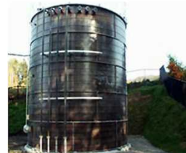
貯湯槽（保温前）
